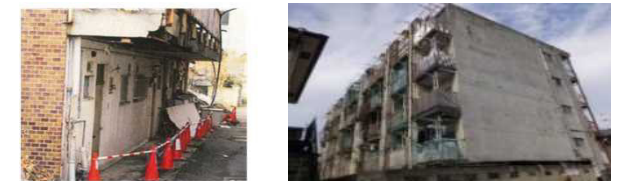
(建物の傷みが著しく外壁の剥落等が生じた事例)
